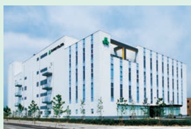
神戸工場・包装技術開発センター(平成20年竣工)
